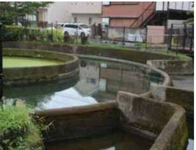
多摩川の2カ所から取水された用水は久地で合流し、下流の「久地円筒分水」で四つの堀に分水される。用水を平瀬川の下をくぐらせ、再び噴出させた水を、放水部円筒を4地区の灌漑面積の比率で正確に4分割して流す。昭和16(1941)年に県の技師・平賀栄治が設計したもので、国の登録有形文化財。
