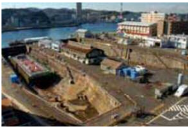
横須賀製鉄所につくられた日本初の石造ドライドック。現在は米軍基地内となるがいまも現役である。
